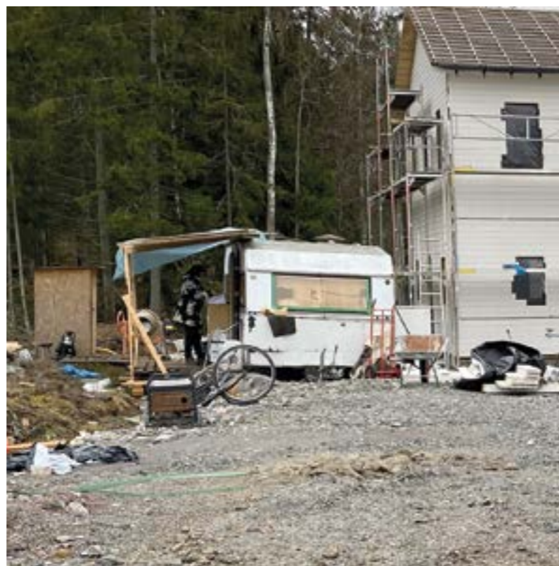
Bild 5. Boende i husvagn och toalett i skjul.
